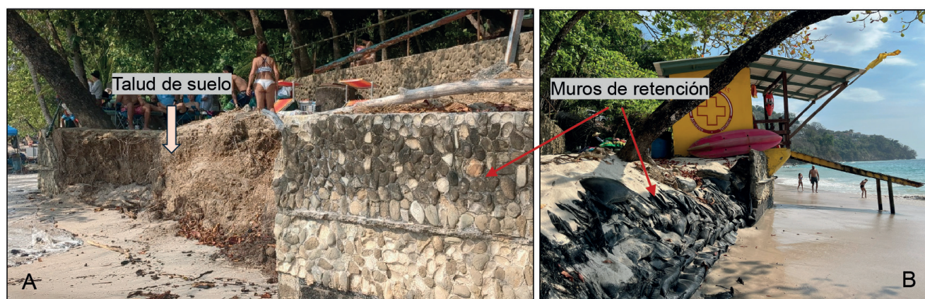
Figura 22. (PC304). Playa Blanca sector central. A) muestra los taludes de suelo producto de la meteorización de areniscas del Miembro Caletas de la Fm. Punta Carballo, que se da por la transición natural del litoral continente – océano y la influencia del oleaje marino. A y B) se muestra también los muros de retención para evitar la erosión costera.
