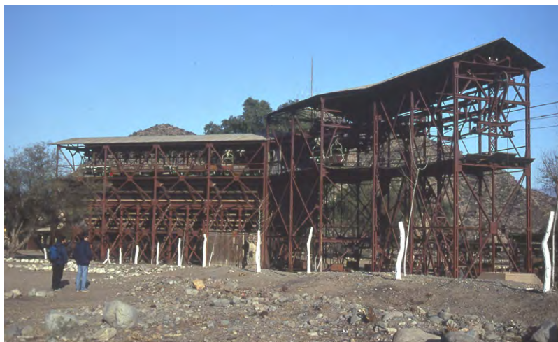
Figura 3. Estación N° 1 en la localidad de Chilecito. Aspecto general de la zona de arribo y salida de las vagonetas. Fotografía: Enrique Miranda.
