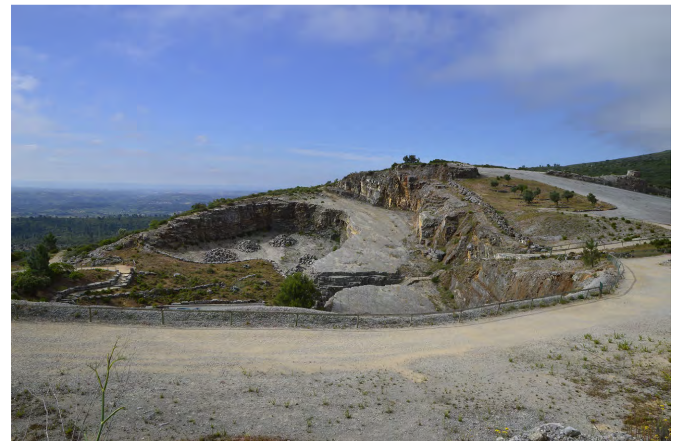
Figura 2. Vista geral da Pedreira do Galinha onde se situa o Monumento Natural das Pegadas de Dinossauros da Serra de Aire. Fotografia: Olímpio Martins.
