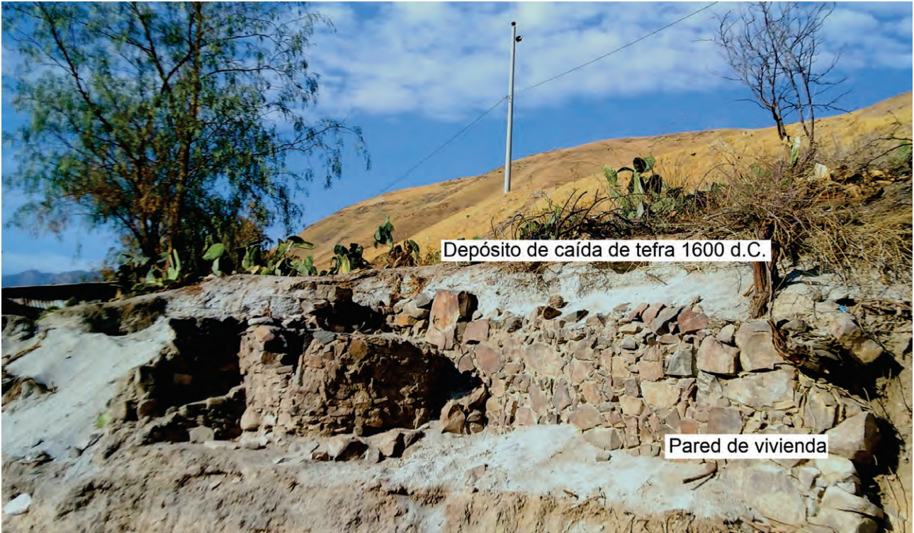
Figura 4. Paredes de viviendas cubiertas por depósitos de caída de la erupción del volcán Huaynaputina del año 1600 d.C. (Sector San Juan de Dios, Omate). Figura: J. Mariño.
