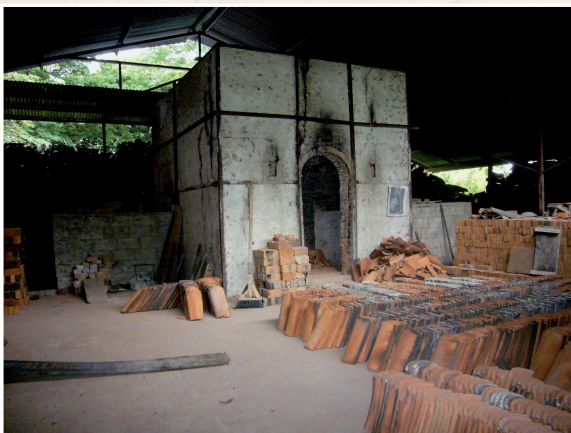
Horno en fábrica artesanal de tejas y ladrillos
